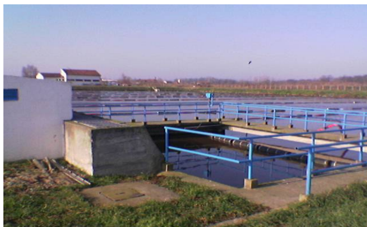
Слика 37. Део биоаерационе лагуне у оквиру постројења за прераду отпадне воде у В.Плани
