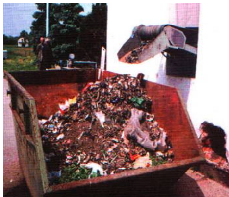
Слика 23. Уклањање крупних честица из отпадне воде механичким поступцима [15]
