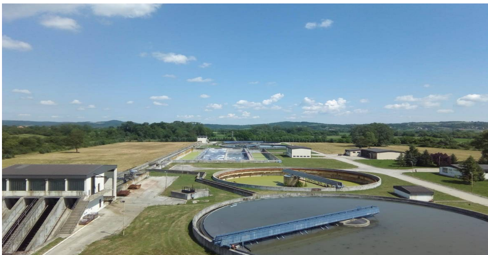
Слика 35.Изглед постројења за пречишћавање отпадних вода у Крагујевцу
