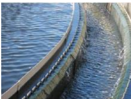
Слика 42. Преливни систем секундарног таложника [21]
