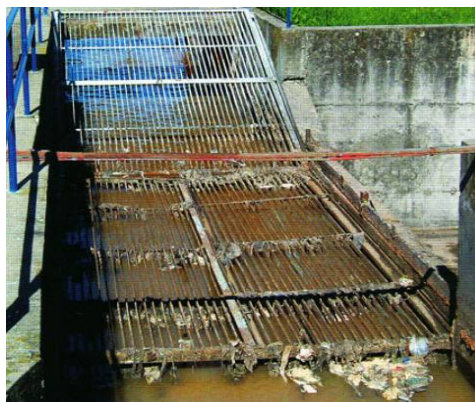
Слика 23. Уклањање крупних честица из отпадне воде механичким поступцима [15]
