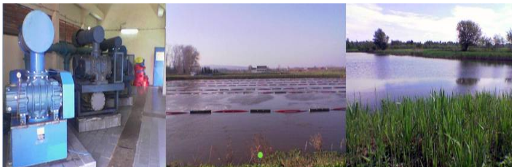
Слика 29. Биоаерационе лагуне за пречишћавање вода и компресор за удување ваздуха
