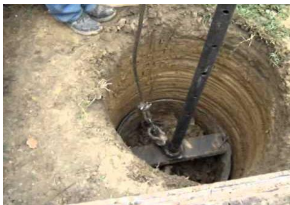
Слика 4.14. Пример бушења бунара
