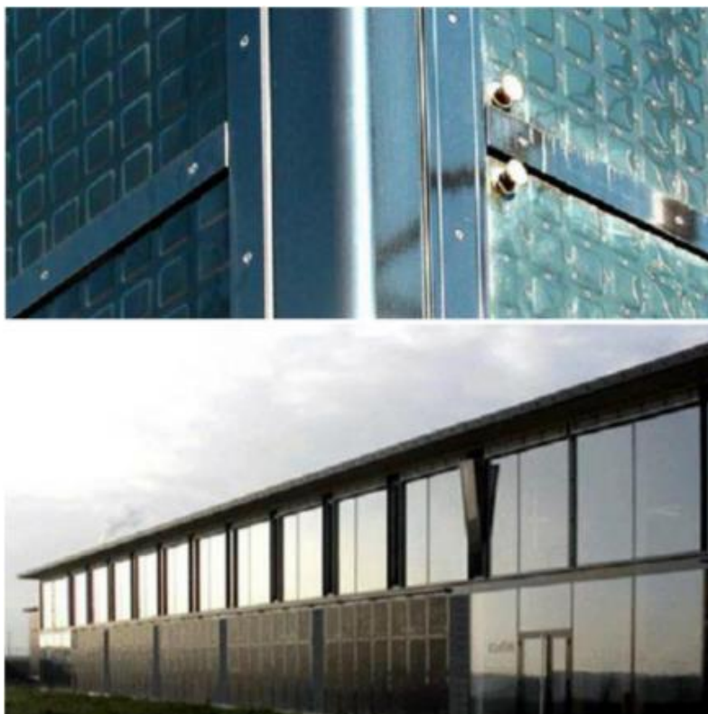
Слика 32. Пример интеграције пријемника од незастакљених равних плоча у фасади као мултифункционалних елемената омотача, Institut Cern , Швајцарска [20]
