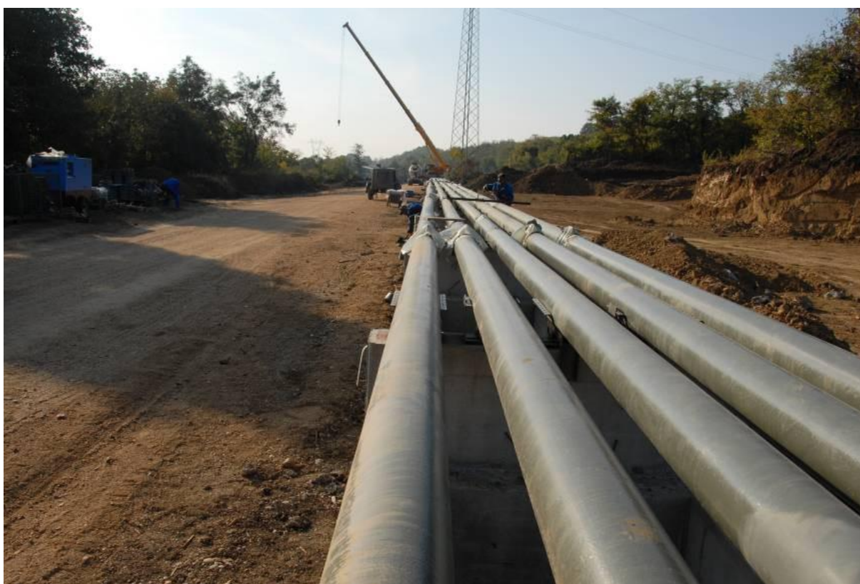
Slika 7.1. Trasa cevovoda hidromešavine ka deponiji
