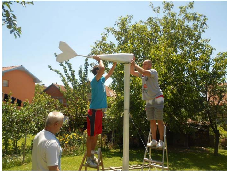
Слика 18: Постављање ветрогенератора 3
