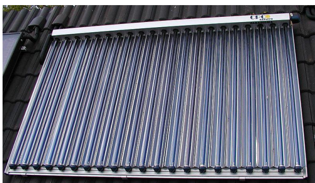
Слика 6.3 Соларни колактор са вакуумским цевима
