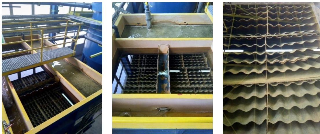
Слика 38. Ламела сепаратори – приказ ламела
