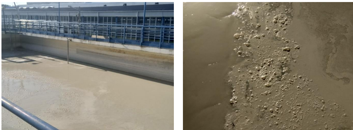
Слика 41. Прихватни и егализациони базен за технолошке отпадне воде 2
