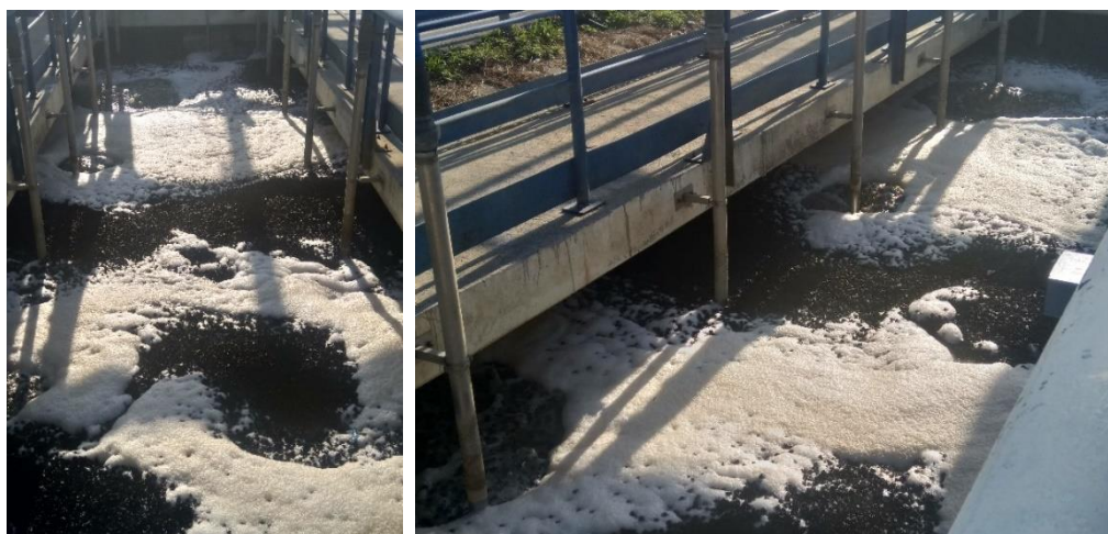
Слика 44. Носачи Б филма у МББР базену
