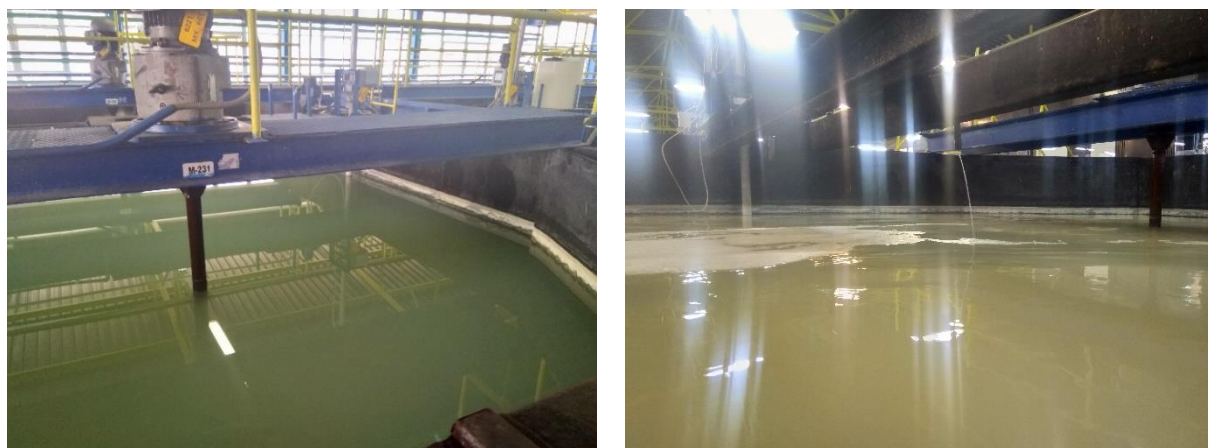
Слика 34. Процес коагулације – додавање коагуланата
