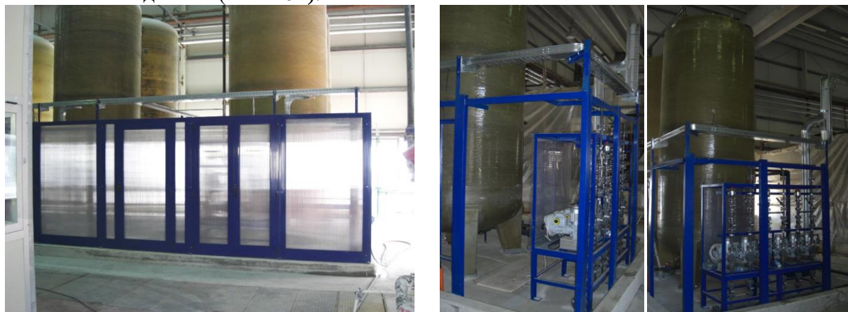
Слика 52. Складиштење и дозирање хемикалија
