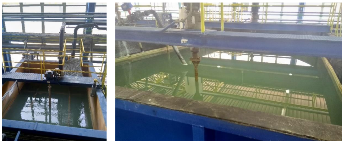
Слика 35. Базификација отпадне воде због регулисања \text{pH} вредности
