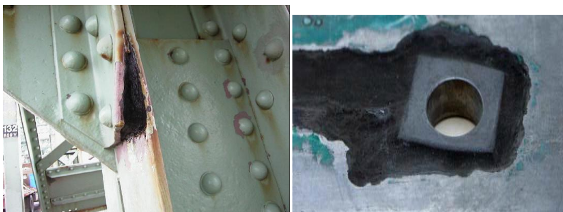
Слика 2.15 Примери корозије у зазорима
