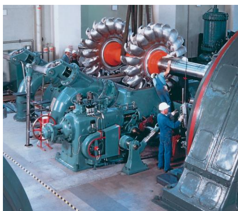
Слика 3.13: Хоризонтална Пелтонова турбина
