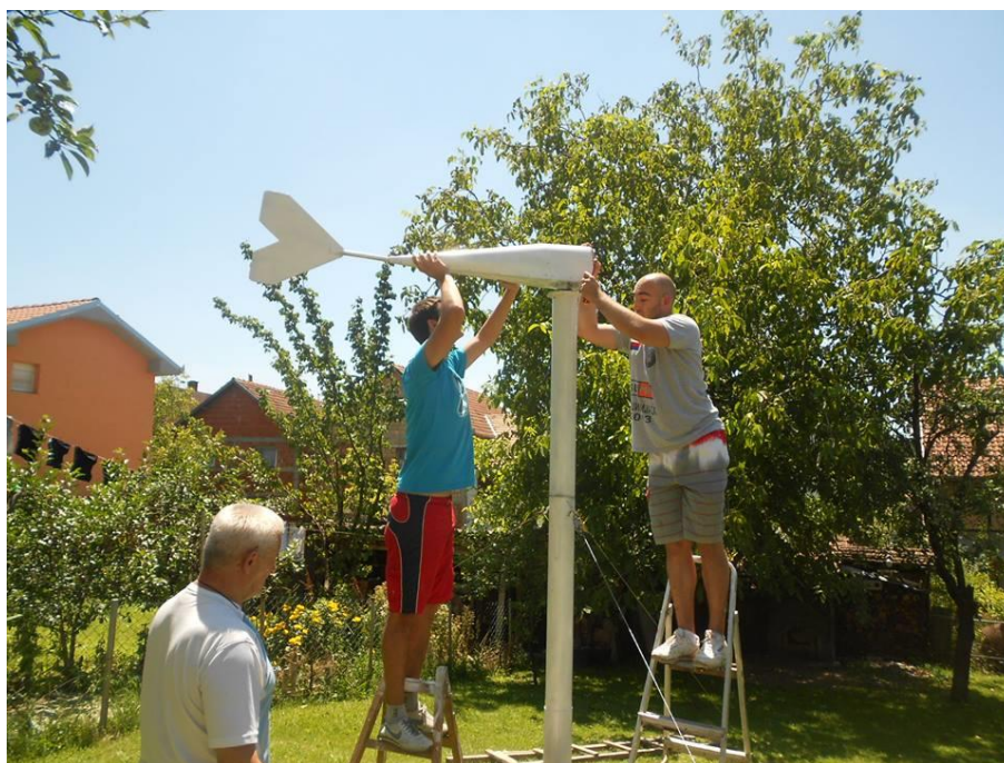
Слика 26: Постављање ветрогенератора
