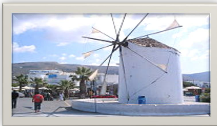
Слика 7: Рана врста ветрењаче са хоризонталним вратилом 13
