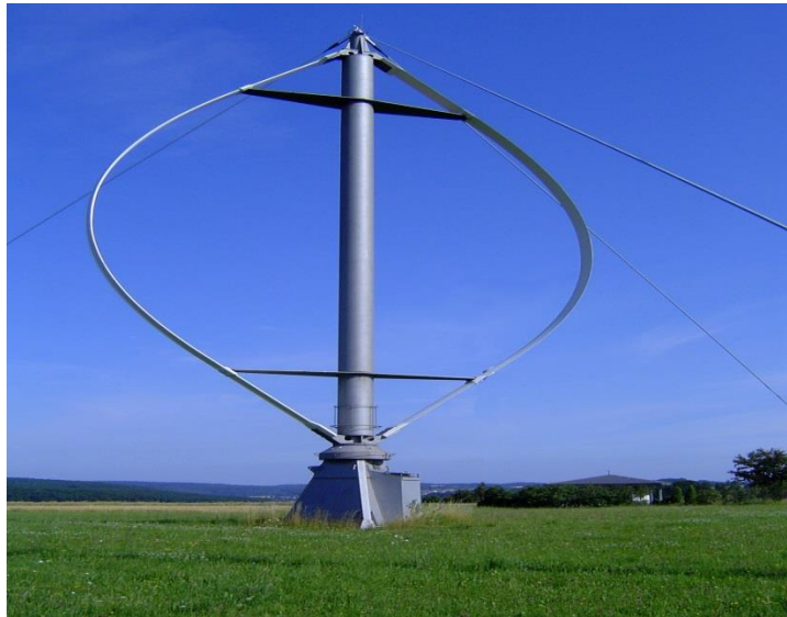
Слика 10: Дариус турбина, ветрењача са вертикалним вратилом 17
