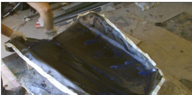
Слика 38. Наношење другог слоја везивног материјала на угљенична влакна
