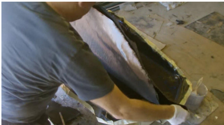
Слика 39. Постављање другог слоја угљеничних vlakana
