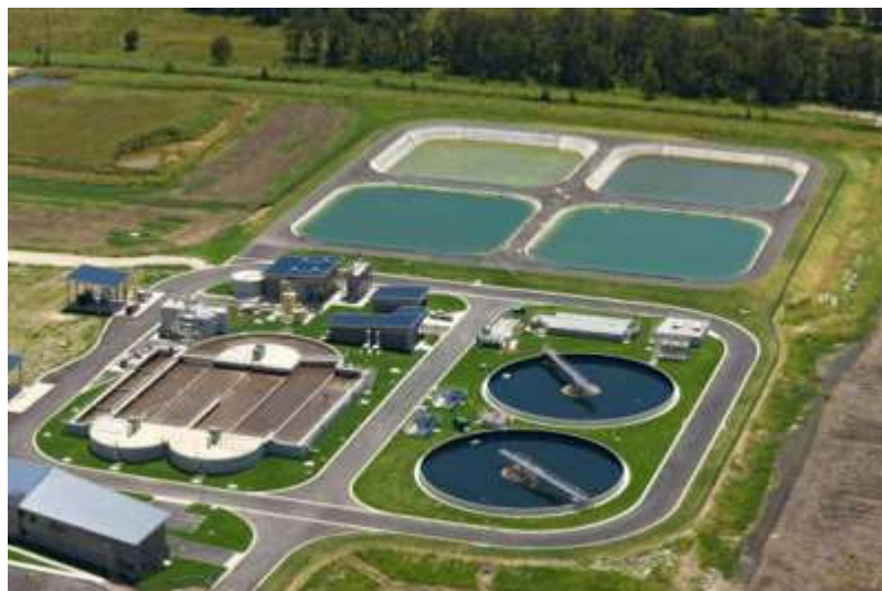
Слика 9. Постројење за пречишћавање отпадне воде [15]
