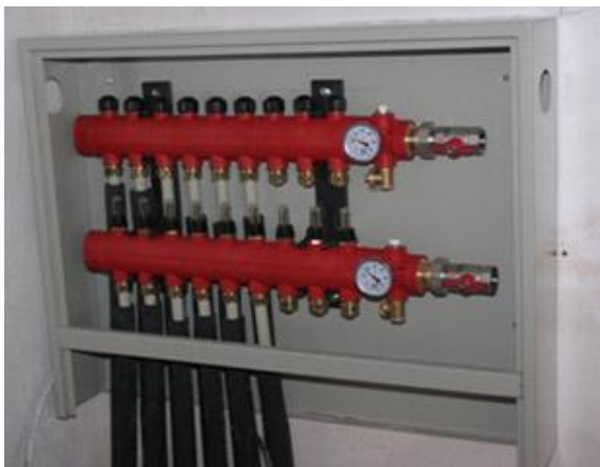
Слика 23. Сабирник и разделник за подне панеле
