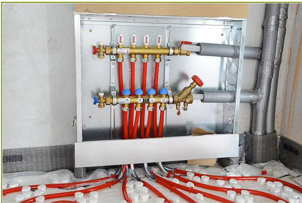
Слика 22. Везивање подних панела са сабирником и разделником
