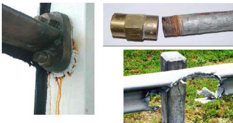
Слика 2.2. Галванска корозија
