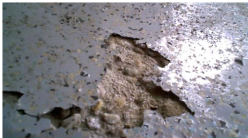
Слика 14. Лоше наношење премаза [14]
