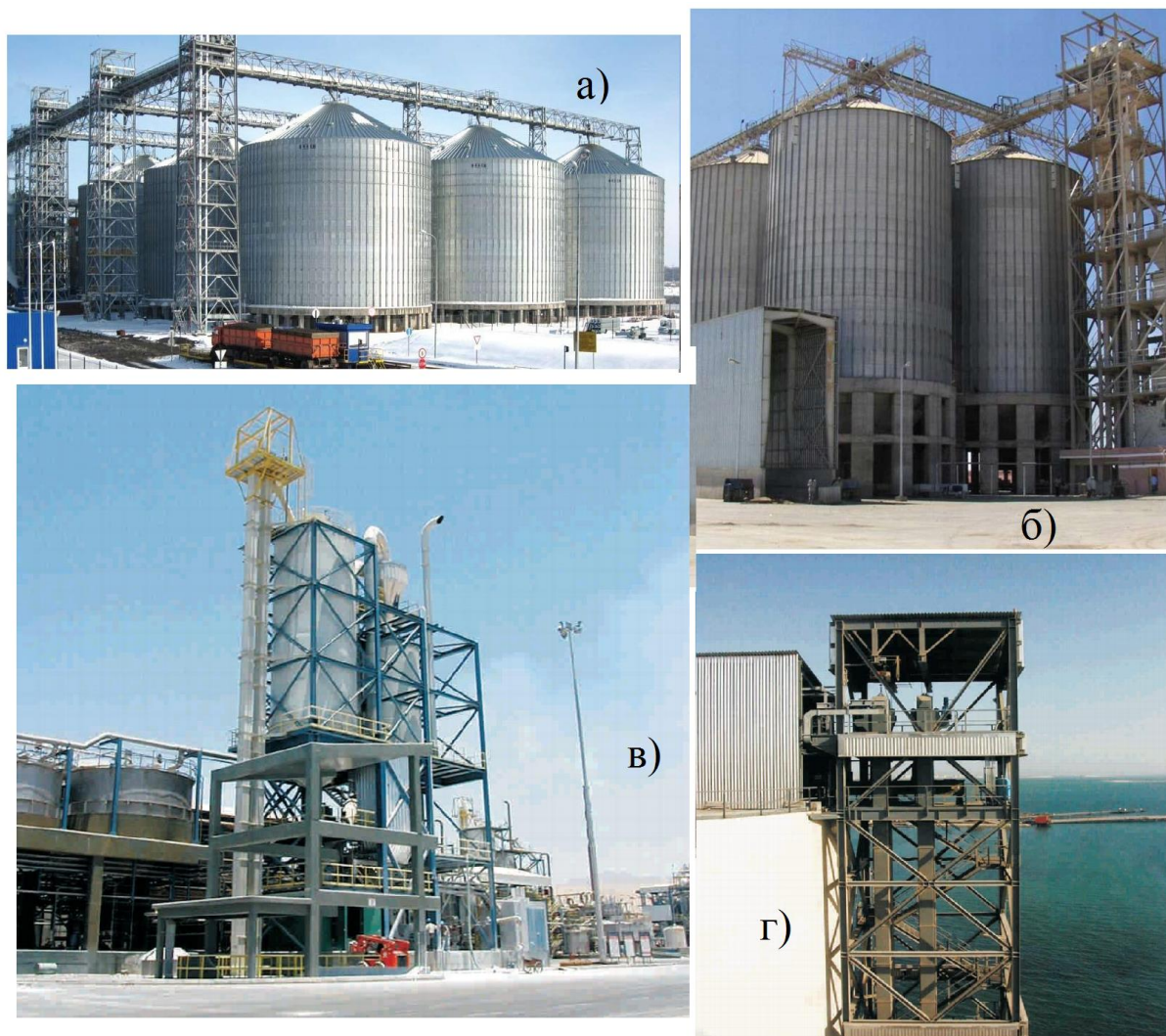
Слика 2.19 Примери коришћења кофичастих елеватора, а) Елеватор у Русији који се користи за складиштење уља, б) Елеватор у Египту за транспорт пластичних опиљака, в) Елеватор у Бахреину за транспорт кокса, г) Елеватор у Јордану за транспорт пољопривредних ђубрива [7]
