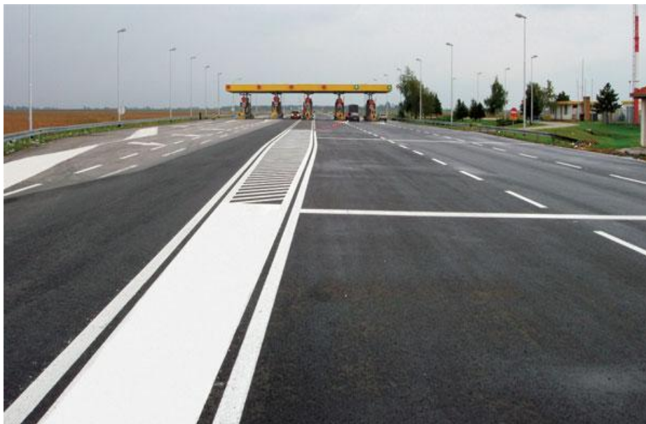
Слика 9. Хоризонтална сигнализација [30]
