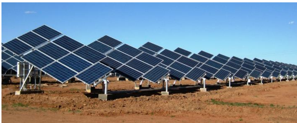
Слика 7. Нагнути једноосни тракер
