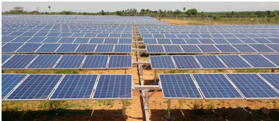
Слика 5. Хоризонтални једноосни тракер
