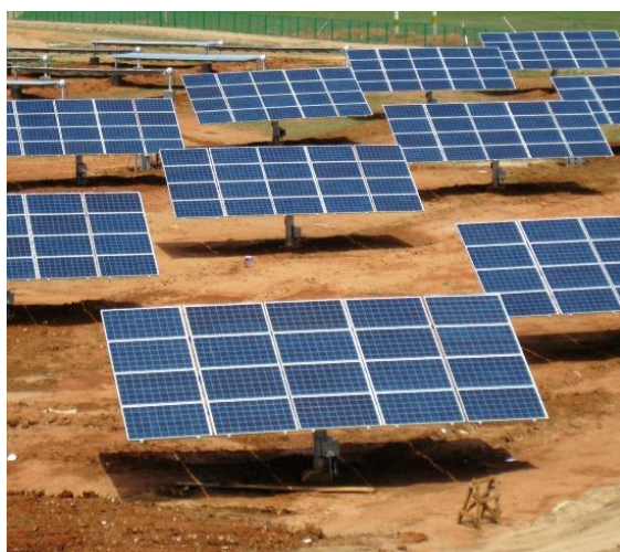
Слика 8. Нагнути двоосни тракер
