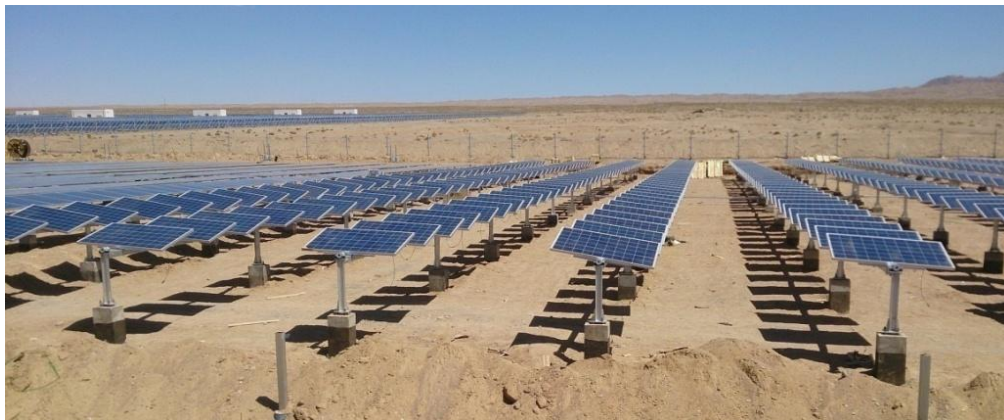
Слика 6. Хоризонтални једноосни тракер са косим модулима
