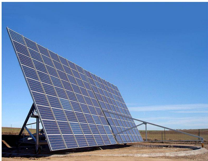
Слика 9. Азимут - двоосни тракер
