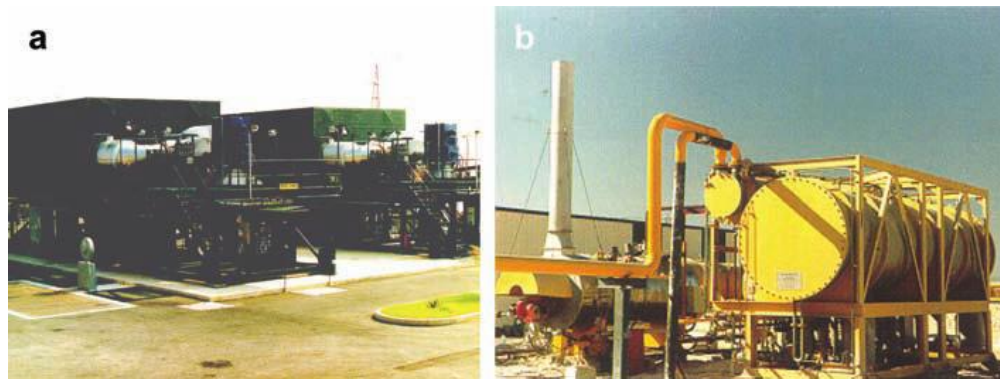
Слика 39 Конвенционална постројења за парну компресију; а) MVC постројење на Сицилији (Извор: SIDEM), б) TVC постројење на Suez (Извор: Weir Westharth Ltd.)
