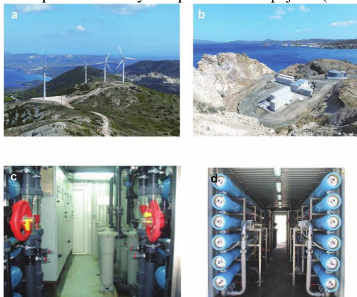
Слика 37 Преглед ветро РО јединице на острву Milos, Грчка; а) ветропарк, б) РО јединица, в) контролна просторија РО јединице, г) РО модули и контејнери [55]
