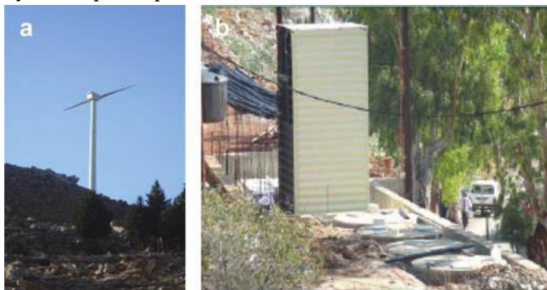
Слика 43 Аутономно ветро-MVC постројење на острву Суми, Грчка; а) 800 \text{ kW} ветротурбина, б) MVC десалинизацијска јединица
