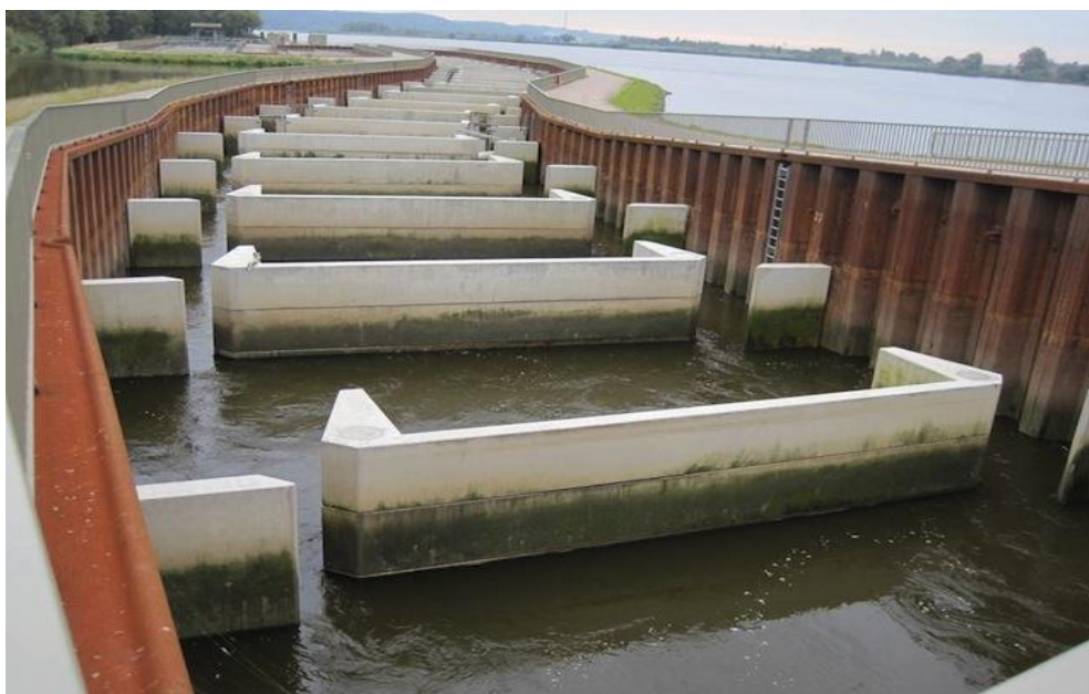
Слика 49 Приказ рибе стазе са вертикалним прорезима [32]
