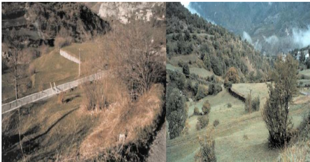
Слика 45 Приказ санираног доводног канала [30]
