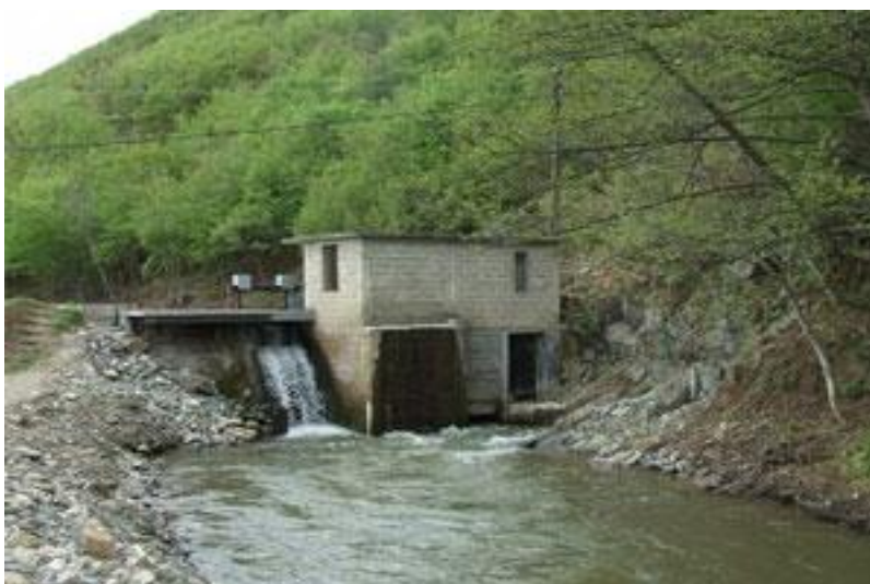
Слика 7 Проточна мала хидроелектрана [11]
