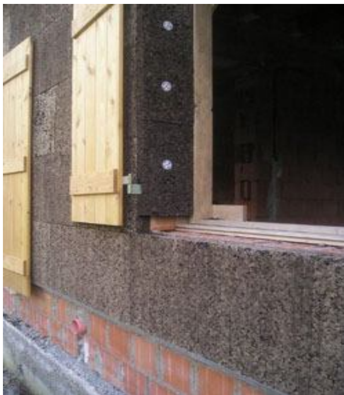
Слика 2.1-11 Облагање фасаде плутом
