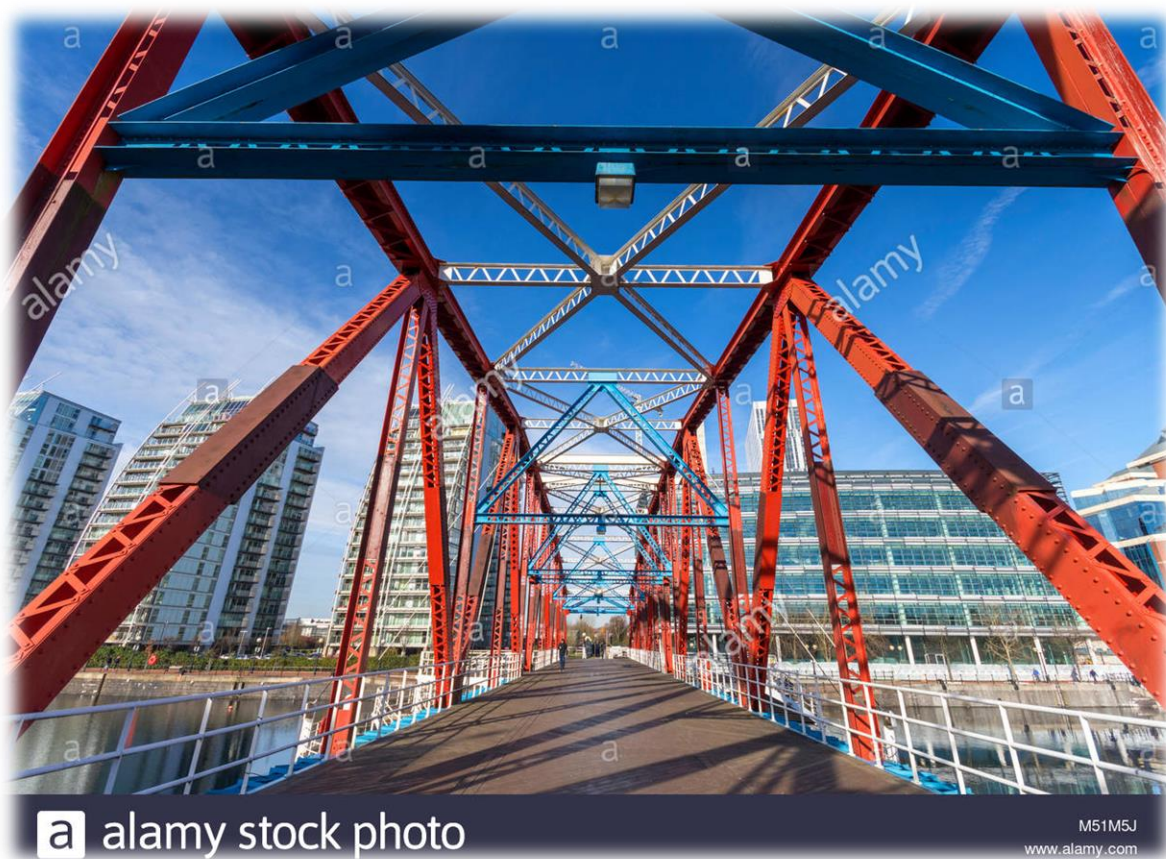
Слика 19 – Мост у Детроиту, примена решеткастих носача [15]
