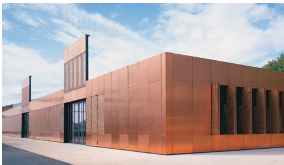
Слика 7.3 Бакарна фасада
