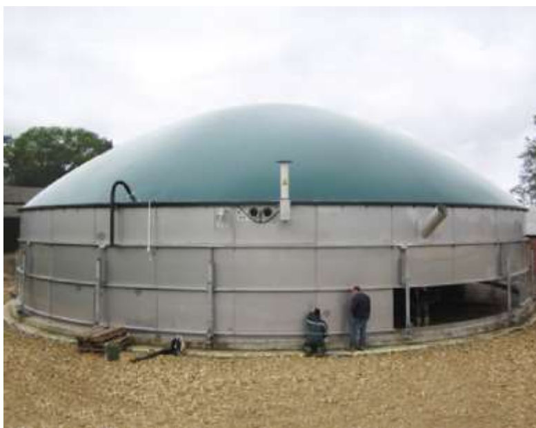
Слика 16. Ферментор од нерђајућег челика у изградњи [16]
