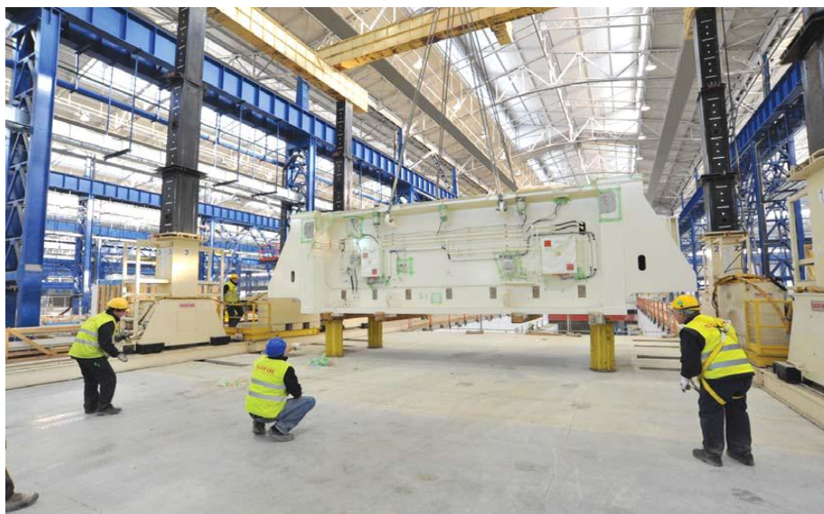
Слика 1. Примена стубова са решеткастом испуном и лимених носача у фабричкој хали са мостном дизалицом
