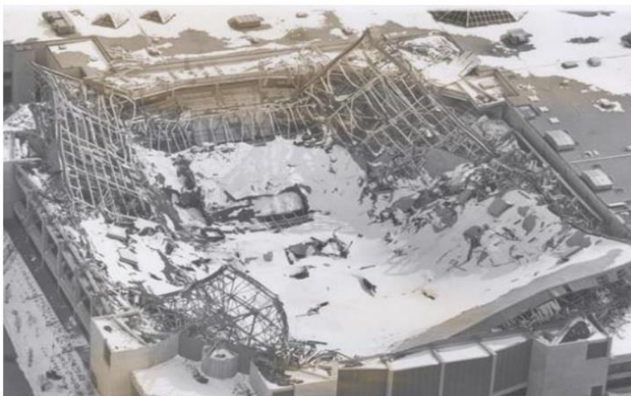
Слика 17 – Пример лома конструкције услед дејства снега, [16]
