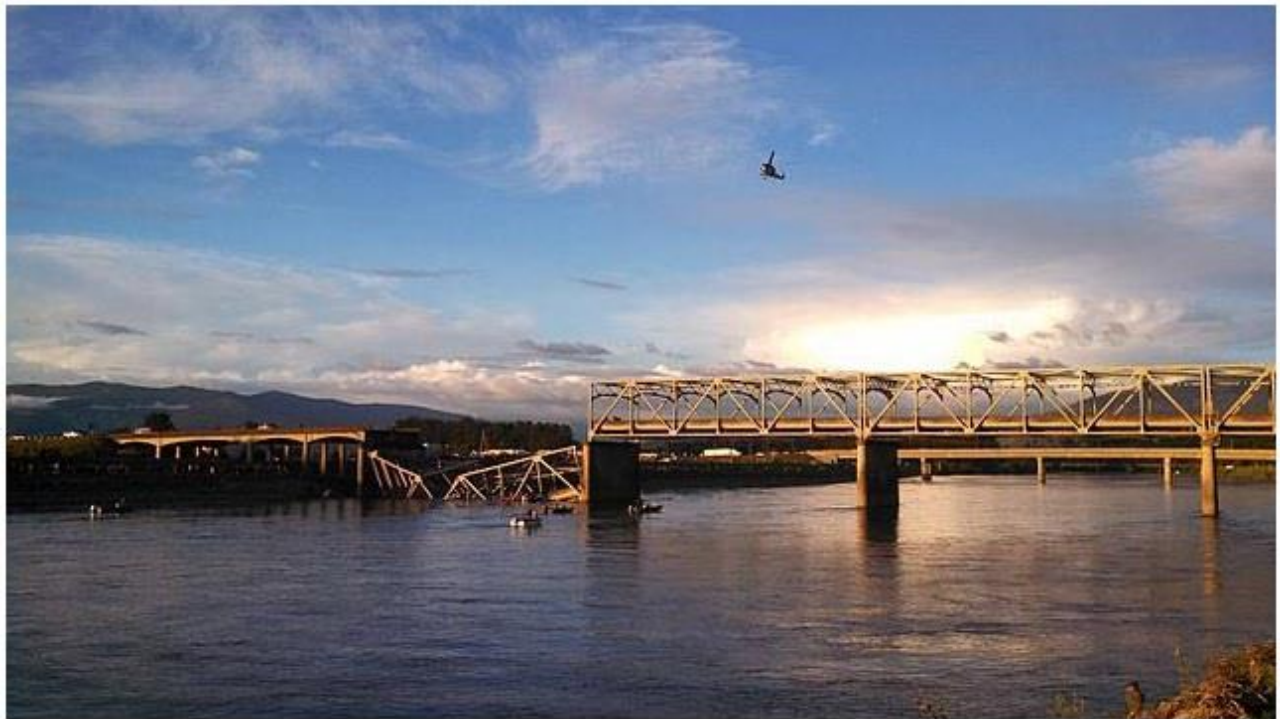
Слика 18 – Пример лома конструкције моста услед дејства ветра, [17]
