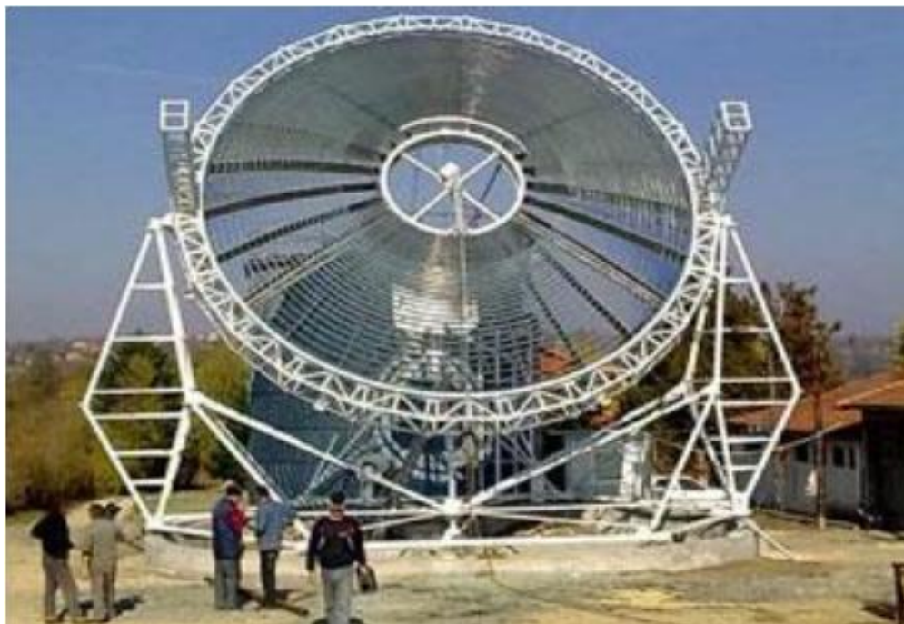
Слика 8. Мала соларна топлана у Бадњевцу, извор топлоте за 500\text{m}^2
