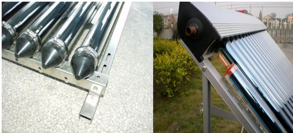
Слика 21. Поступак при демонтажи вакум цеви
