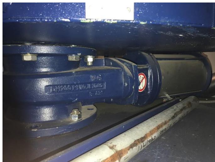
Слика 50. Клапна за испуст испраних мономера
