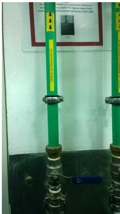
Слика 15. Цевовод за нужно пражњење централних резервоара
