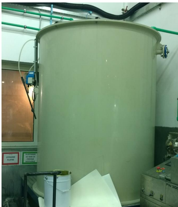
Слика 14. Резервоар за прање дестилерије
