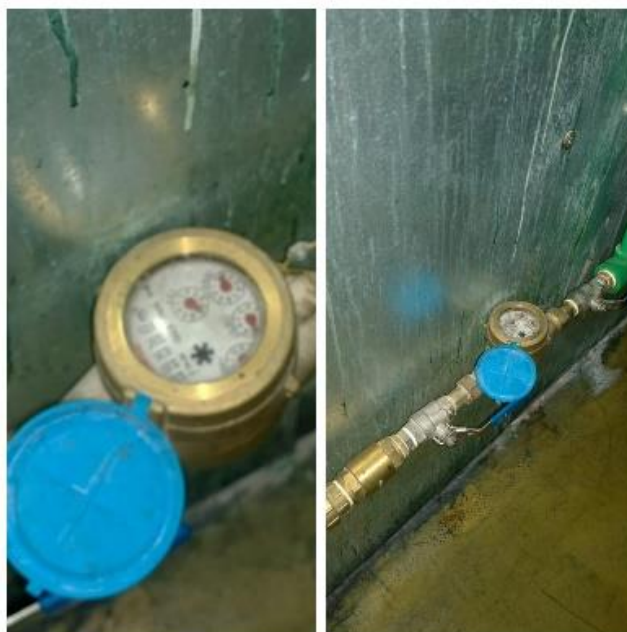
Слика 23. Водомер за мерење издвојене дестиловане воде
