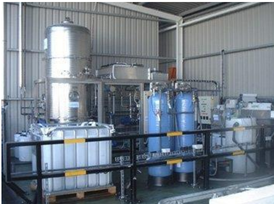
Слика 2. Постојење за третман отпадних вода, модел Envidest LT VS [9]
