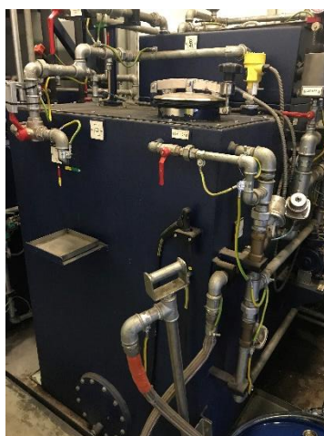
Слика 40. Резервоар Б, за складиштење прљавог растварача
