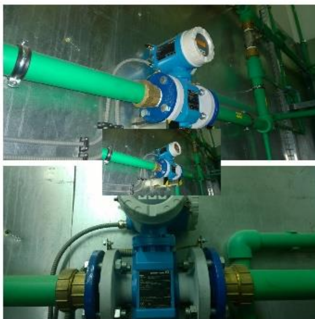
Слика 22. Изглед водомера за мерење улазне количине отпадне воде
