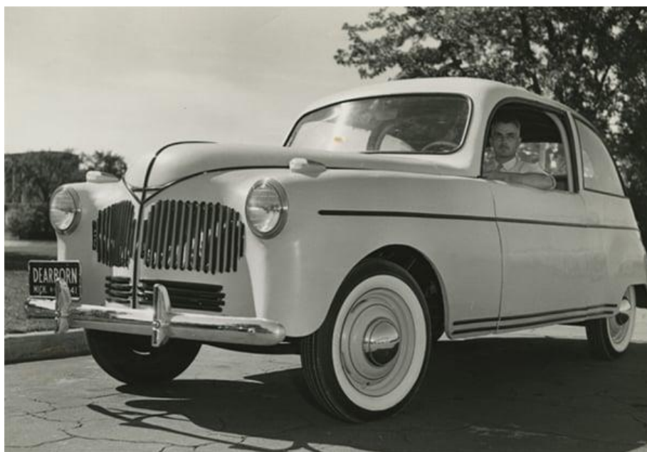
Слика 7.1. – Фордов аутомобил од дурамерног композита са конопљом [25]
