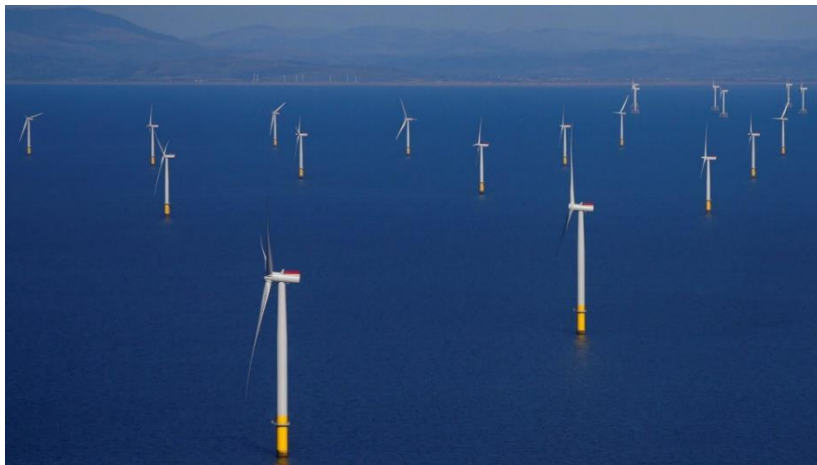
Слика 38. Приобална ветроелектрана Walney [30]
