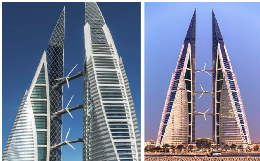
Слика 33. Ветротурбина са хоризонталном осовином (World Trade Center, Bahrain) [26]
