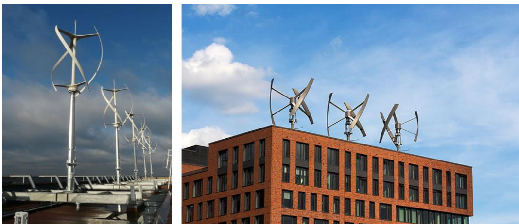
Слика 30. Вентурбине са вертикалном осом обртања, монтиране на крову зграде [25]
