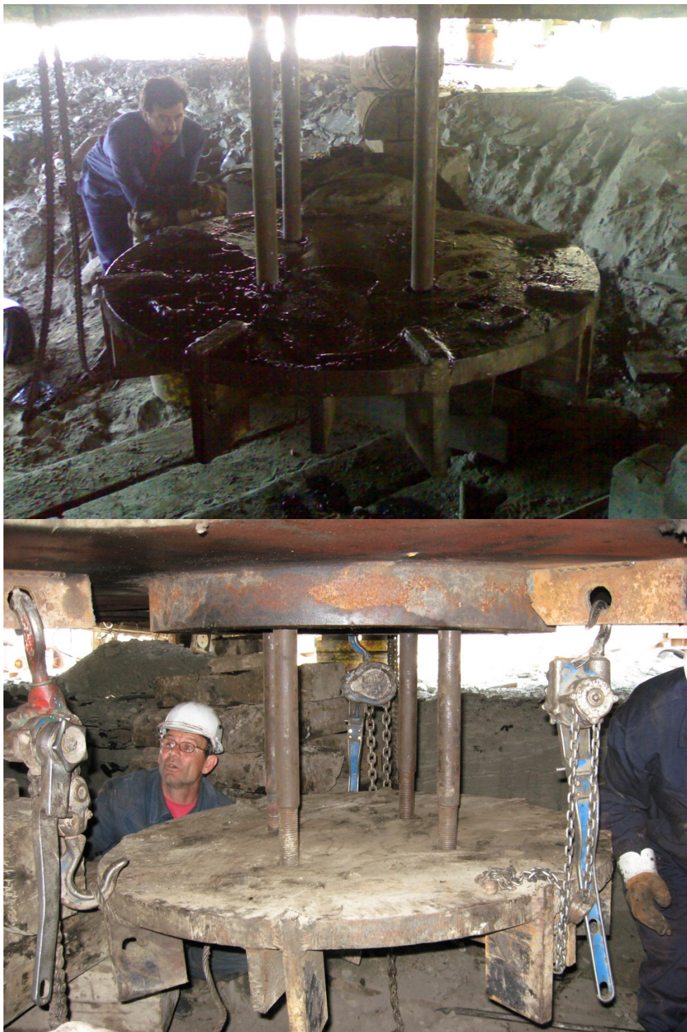
Слика 5.7 – Монтажа алата за демонтажу зупчаника
