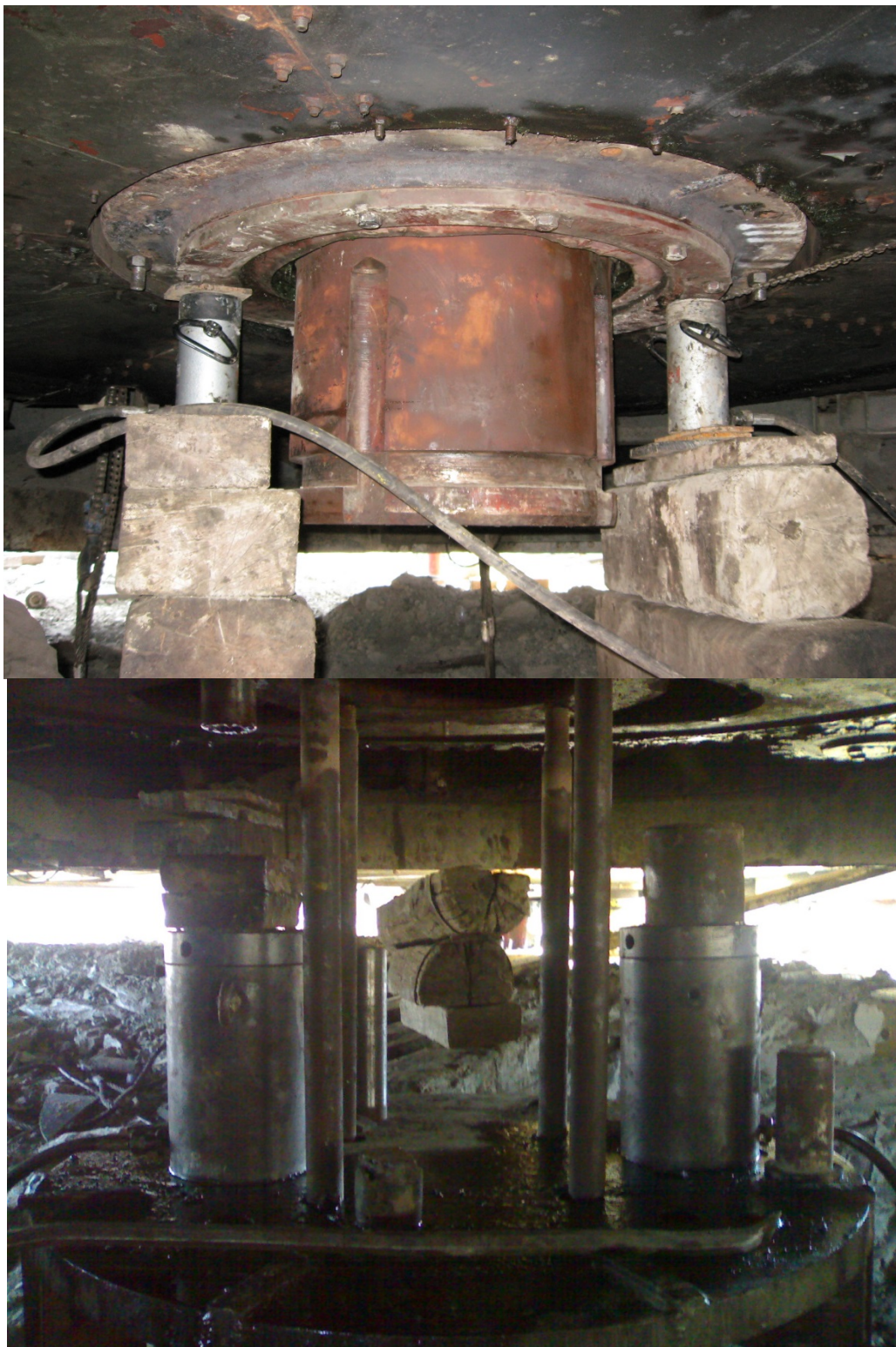
Слика 5.12 – Положај ослонаца и хидрауличких дизалица при монтажи лежаја и зупчаника
