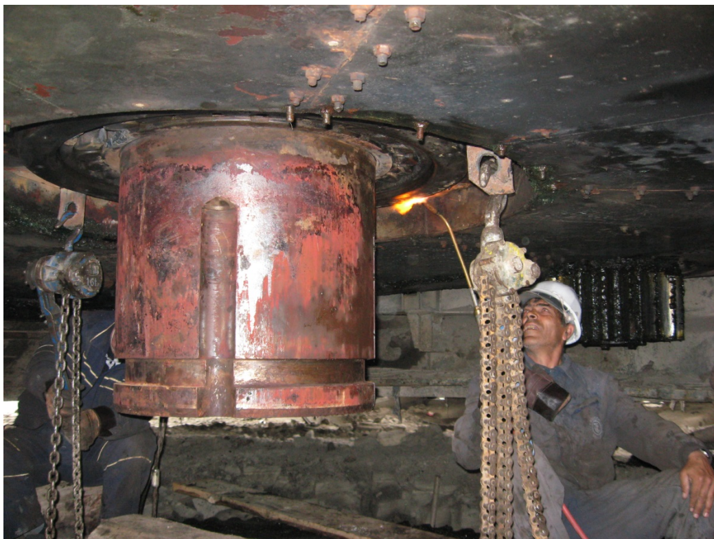
Слика 5.9 – Грејање кућишта лежаја ради лакше демонтаже
