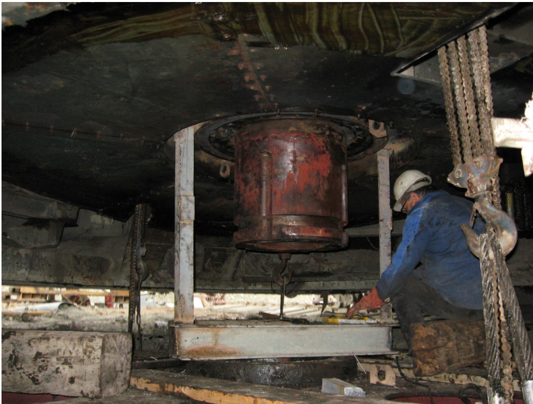
Слика 5.10 – Монтажа импровизованог алата за демонтажу кућишта са лежајем
