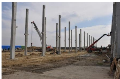
Слика 3.2 Изградња хладњаче са армирано-бетонском конструкцијом [17]
