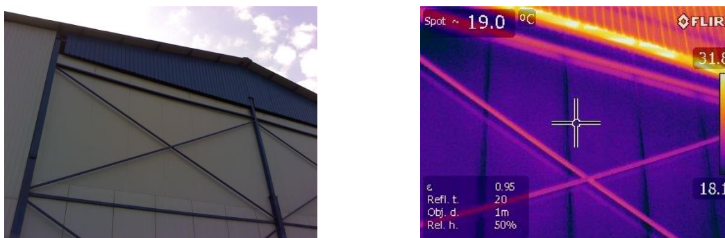
Слика 5.7 Место споја панела и крова
