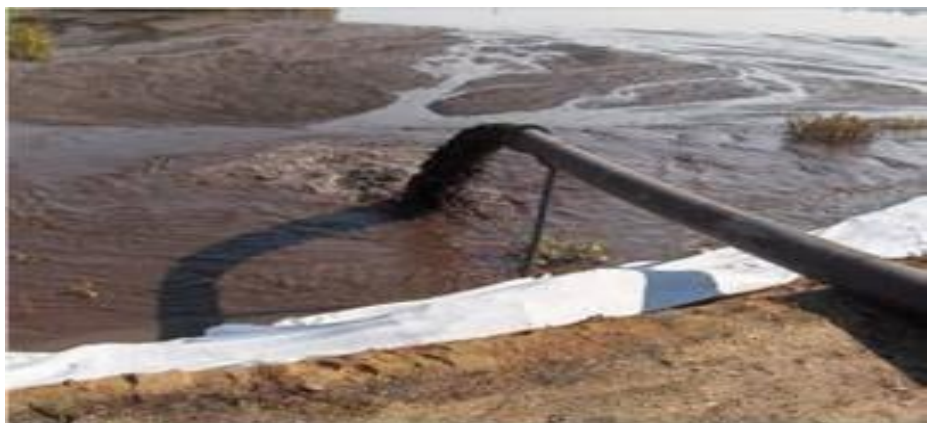
Слика 6 Излив ретке хидромешавине на СКО
