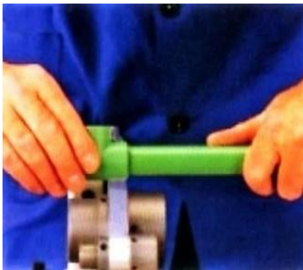
Слика 16. Загревање цеви и колена
