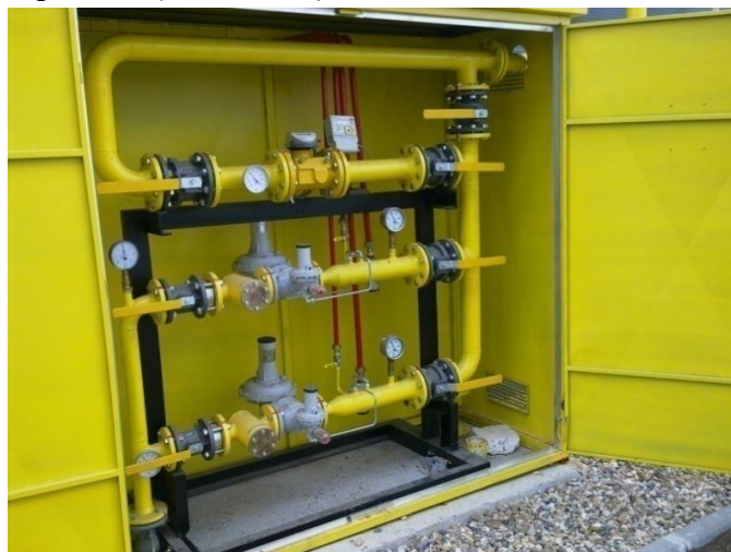
Слика 6.5. Кућна мерно регулациона станица
