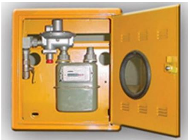
Слика 6.6. Приказ мерно-регулационог сета за гас
