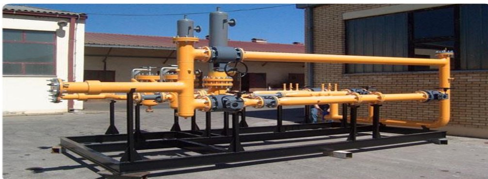
Слика 6.1. Главна мерно-регулациона станица
