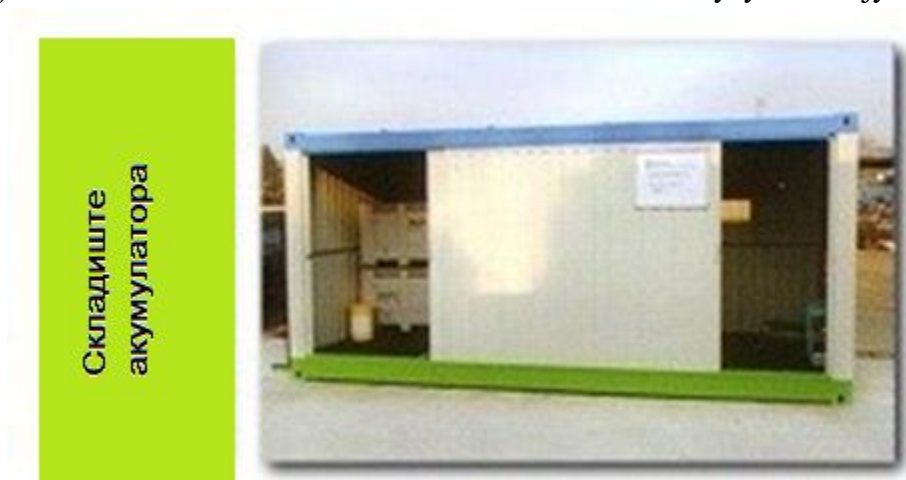
Слика 4. Складиште акумулатора [6]
