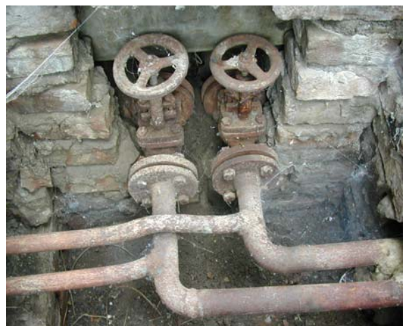
Слике 12.2; 12.3; 12.4 и 12.5: Приказ затеченог стања на одвајањима (шахтама)
