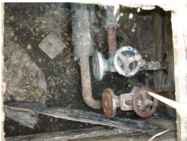
Слике 12.2; 12.3; 12.4 и 12.5: Приказ затеченог стања на одвајањима (шахтама)
