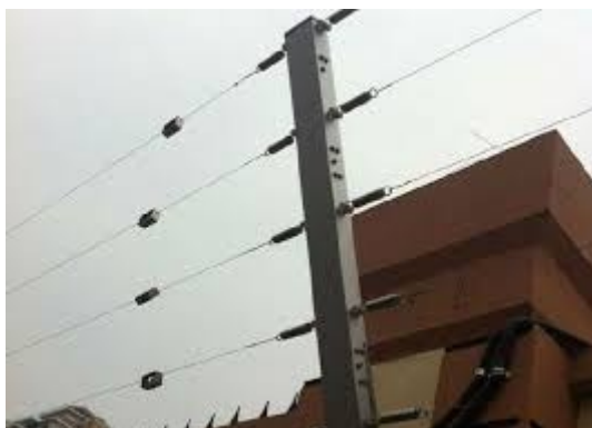
Слика 2.17 Заштита периметра помоћу затегнуте жице
