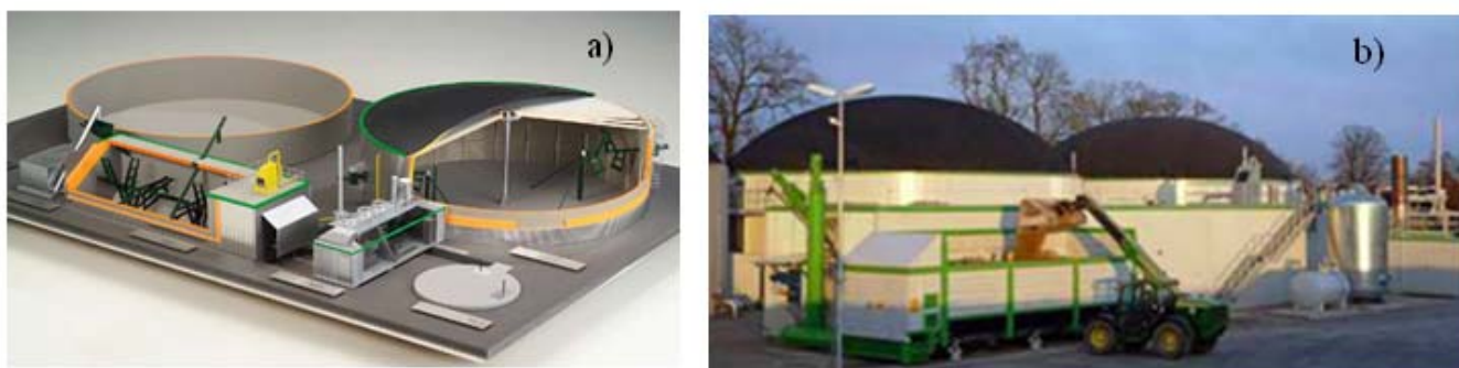
Слика 19 : а) 3Д модел дигестора, б) слика дигестора у природи
