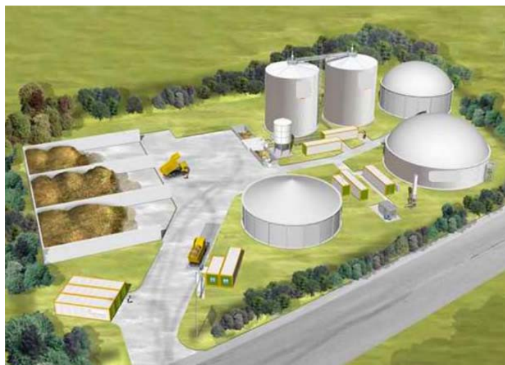
Слика 13 : 3Д модел биогасног постројења са прихватилиштем за стајњак
