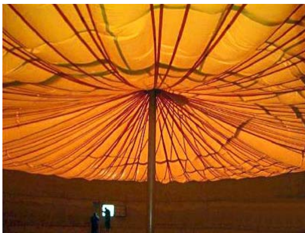
Слика 30 : Складиште гаса - унутрашњи изглед
