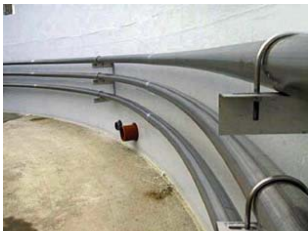
Слика 25 : Грејање резервоара за ферментацију
