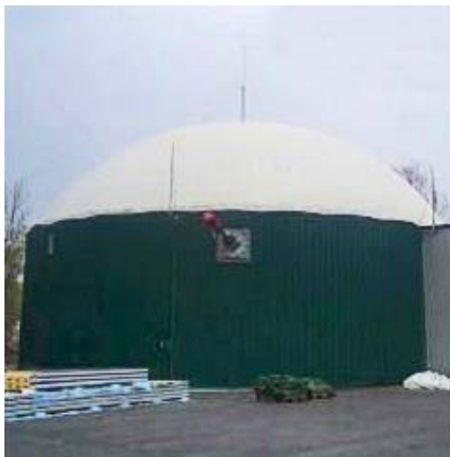
Слика 29 : Складиштење гаса
