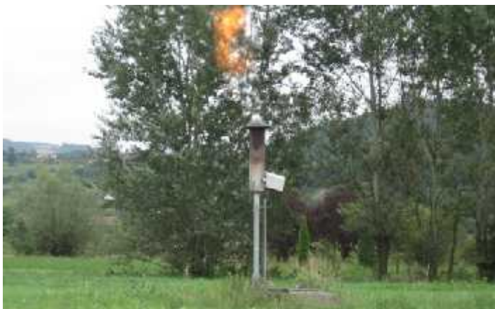
Слика18. Бакља за спаљивање вишка биогаза
