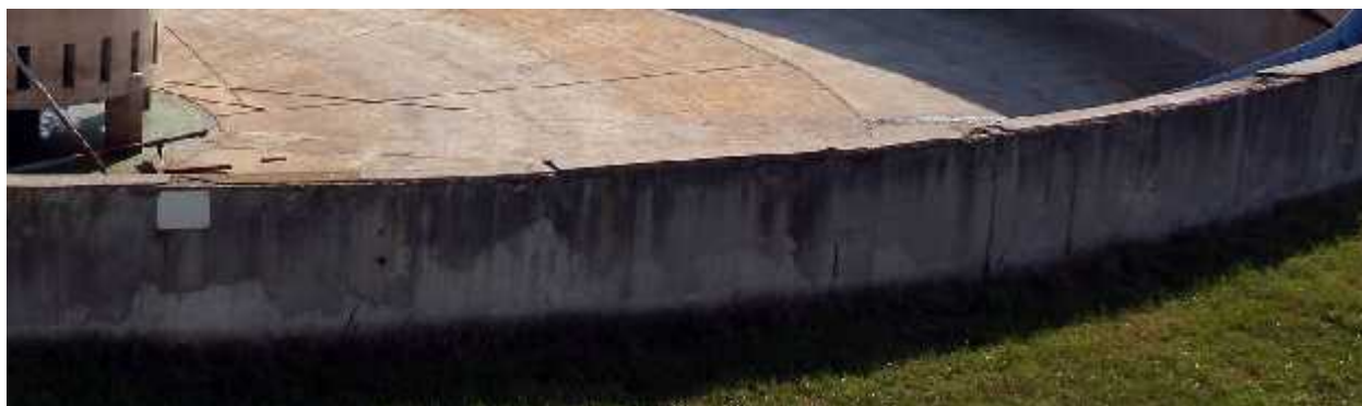
Слика14 .Стазе за вођење моста секундарног таложника
