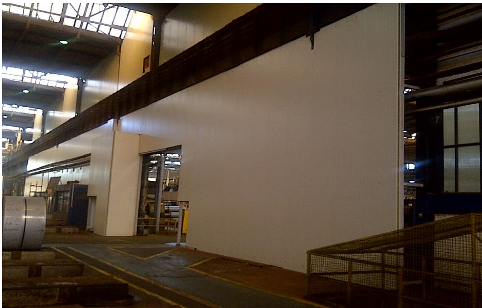
Слика бр.11 Зид између постројења за декапирање и простора за складиштење жарених котурова
