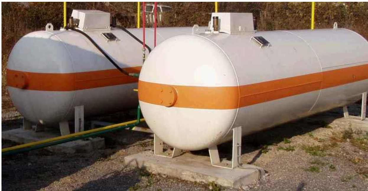
Слика 4. Цилиндрично резервоари за складиштење ТНГ-а
