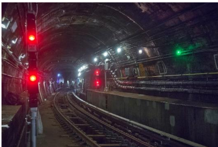
Слика 31. Сигнал "репетитора" у тунелу у улици Монтаже [77]
