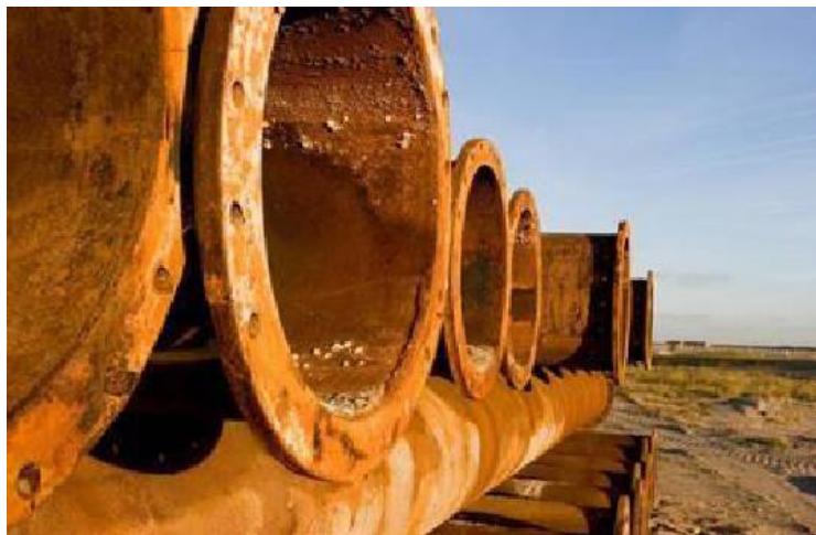
Слика 2.2. Општа корозија [2]
