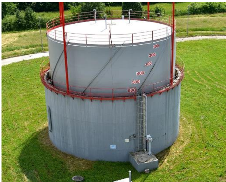
Слика 22. Резервоар за биогаз у склопу постројења у Цветојевцу
