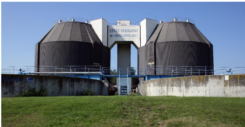
Слика 20. Дигестору у централном постројењу за третман отпадних вода у Цветовецу, Крагујевац
