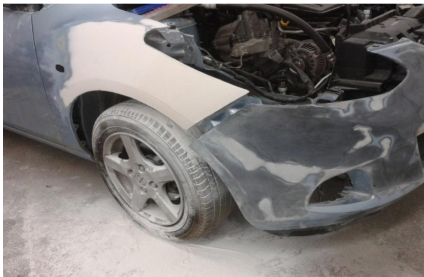
Слика 4.10 Површина обрађена ручно брусним папиром, гранулације 150
