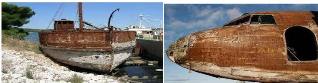
Слика 1. Примери корозије метала [4]
