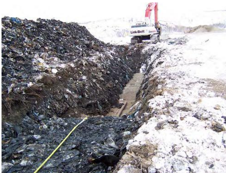
Слика 3.4 Процес изградње хоризонталних канала (ровова)
