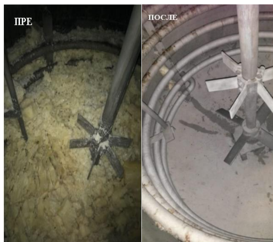
Слика 37. Чишћење унутрашњости резервоара: пре (слика лево) и после (слика десно) [50]
