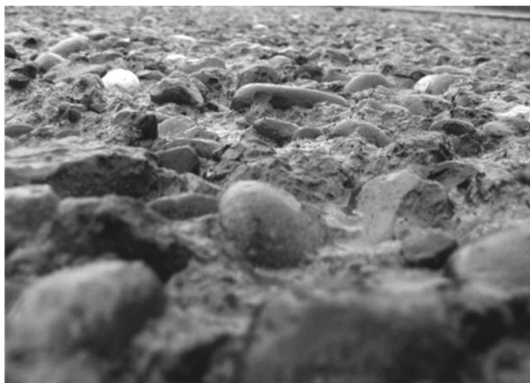
Слика 8. Профил површине након разарања водом [34]
