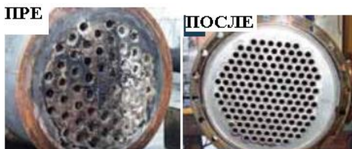
Слика 40. Топлотни измењивач пре и после чишћења [48]
