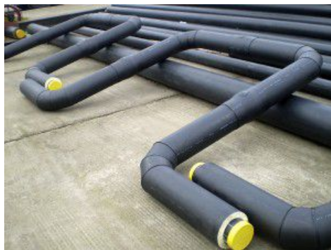
Слика 3. „U“ компензатор
